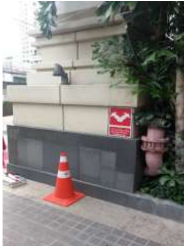
ภาพที่ 5-21 หัวรับน้ำดับเพลิงจากภายนอกอาคาร
