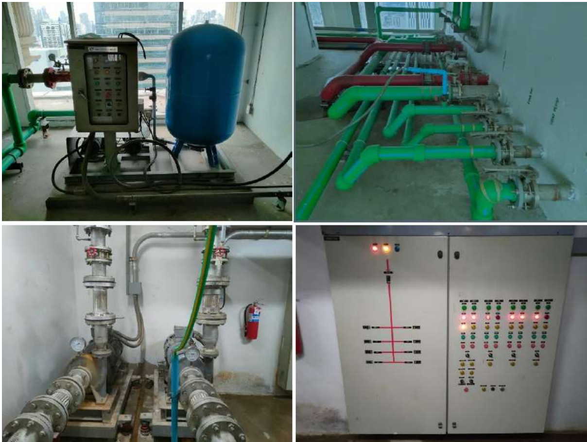
ภาพที่ 5-10 ระบบประปาถังสำรองน้ำ ชั้น ดาดฟ้า
