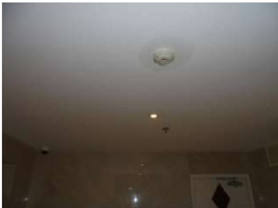
ภาพที่ 5-22 Smoke Detector และ Sprinkler
