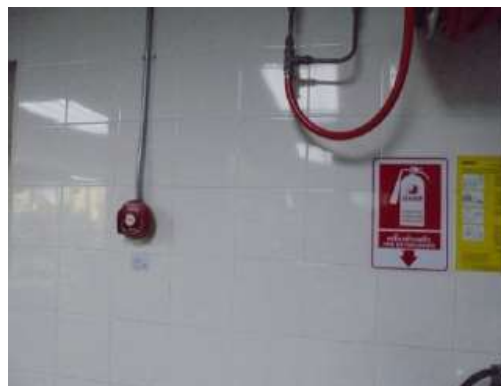
ภาพที่ 5-25 Fire Alarm Bell และ Manual Station
